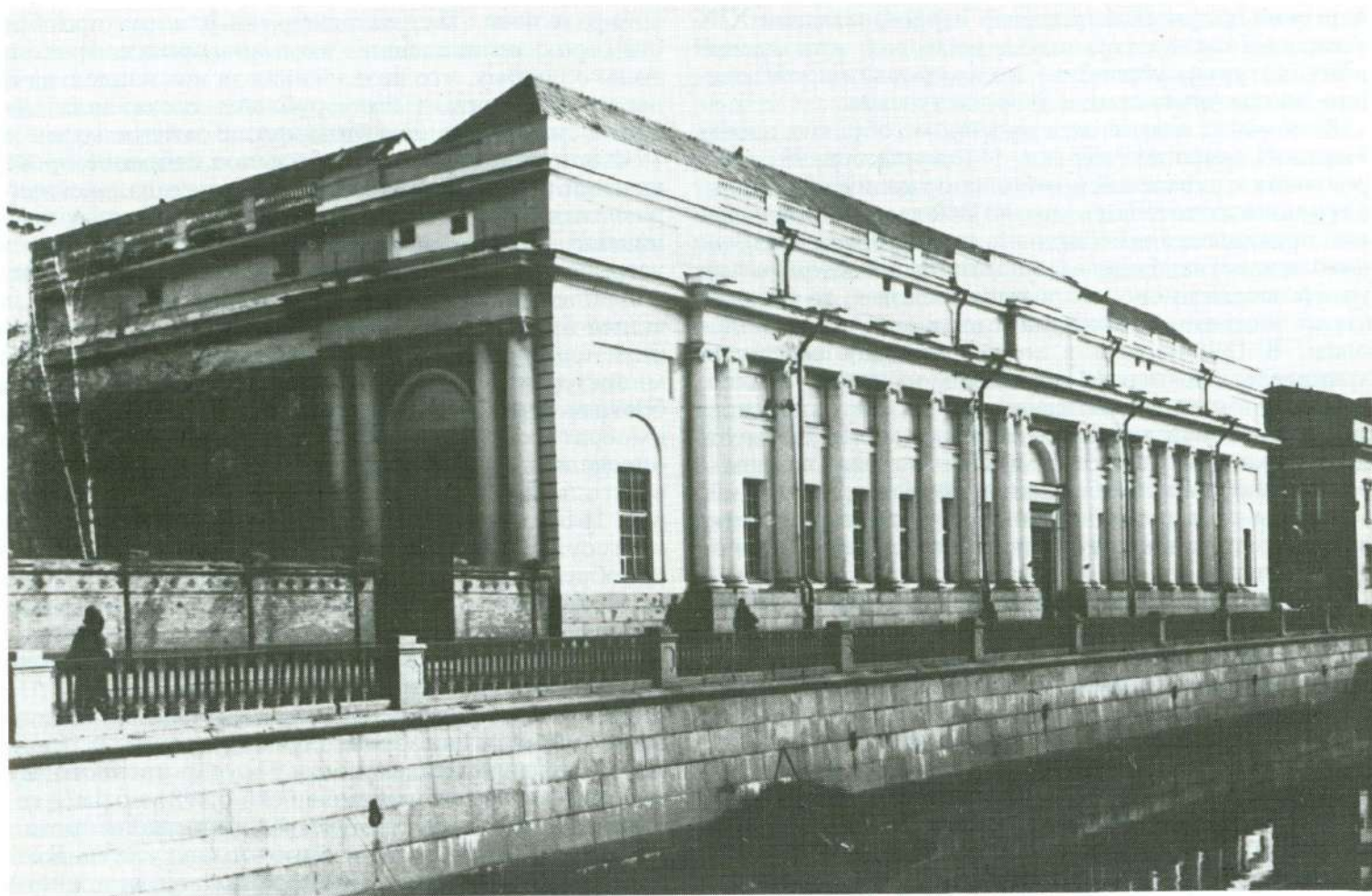
Фасад корпуса Бенуа Вид с набережной канала Грибоедова
